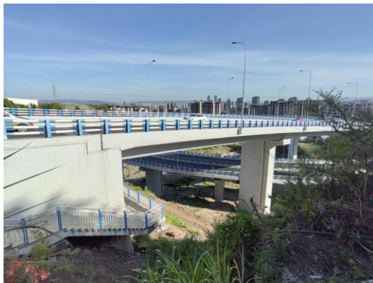
工程竣工后立交下现状（1）
