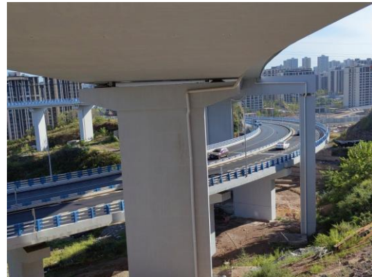
工程竣工后立交下现状（2）
