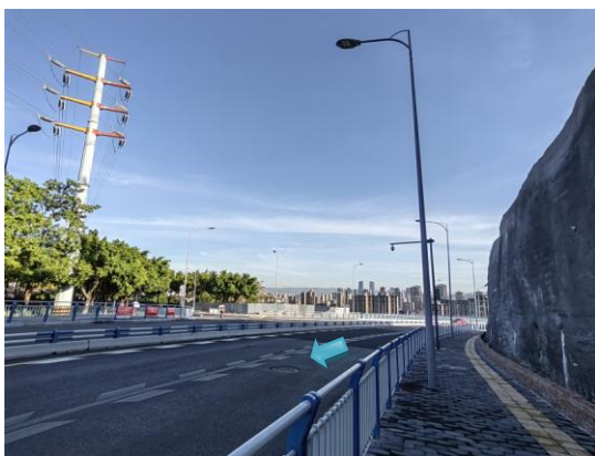
车行道上雨水检查井
