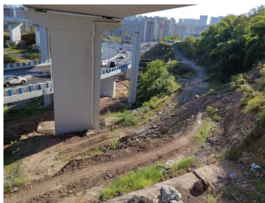
螺旋立交桥面径流导排管
